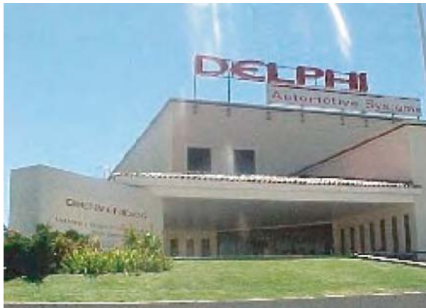
Alambrados y Circuitos Eléctricos, S.A. de C.V.
